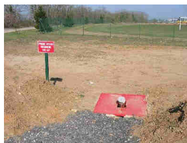
La réserve enterrée
