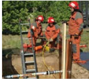
- sauvetage dans des tranchées effondrées
