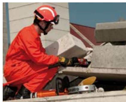
Une combinaison parfaite: démolir du béton avec la CC 20 C et couper les barres d'armature avec la mini-cisaille CU 4007 C (ou SMC 4006 C).
