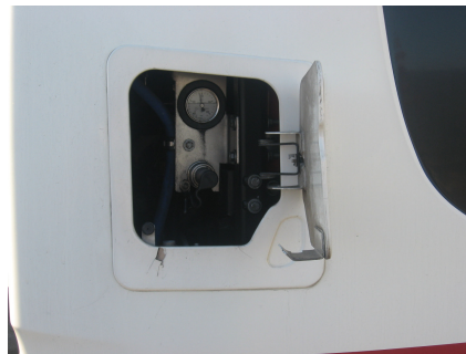
Raccordement côté bus
